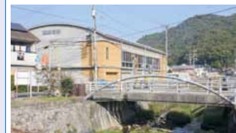
現在 橋も架けかわり内海小の体育館になっている
